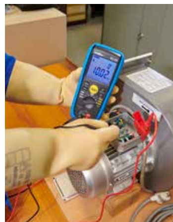
Maintenance préventive sur moteur
