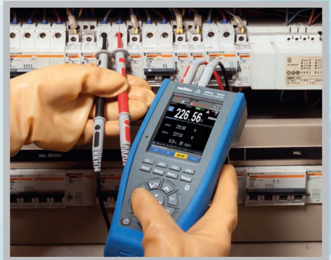
Mesures sur armoires électriques
