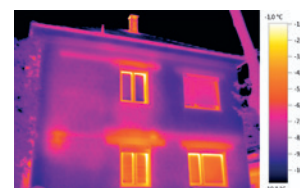
Image thermique avec testo ScaleAssist
