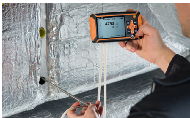
Appareil amovible permettant des mesures dans les canalisations au moyen d'un tube de Pitot (tube de Pitot disponible séparément)
